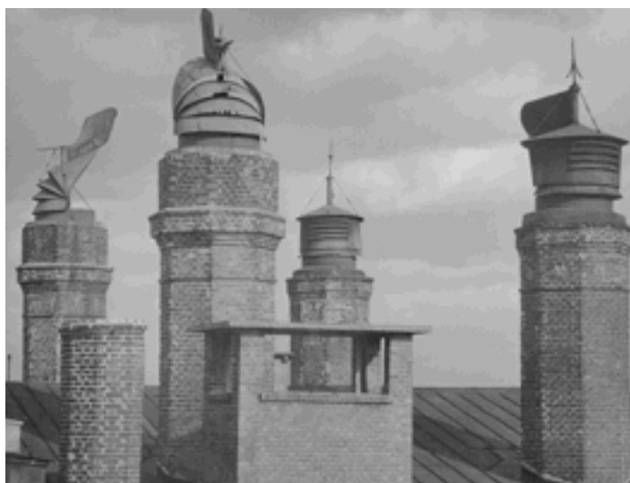
Abb.5 Abluftkamin der 1950/51 im (1978 abgebrochenen) „vorderen“ Darrhaus eingebauten direkt beheizten Einhorden-Darre („Müger“)
